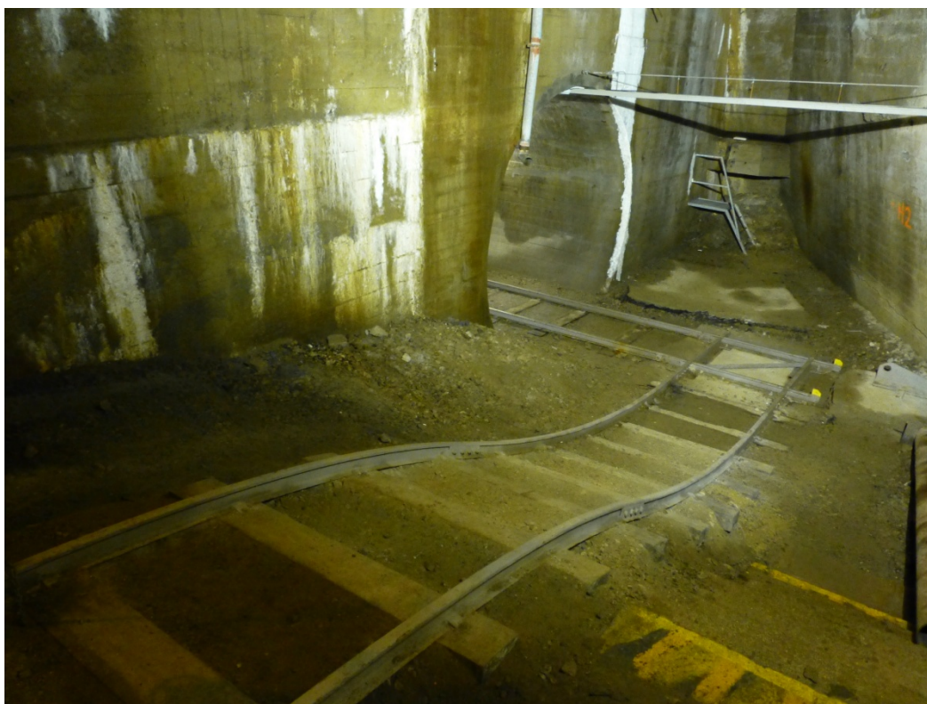
Obr.6 Změna úrovně kolejové dráhy za tunelem č.2, vjezd do tunelu č.3
