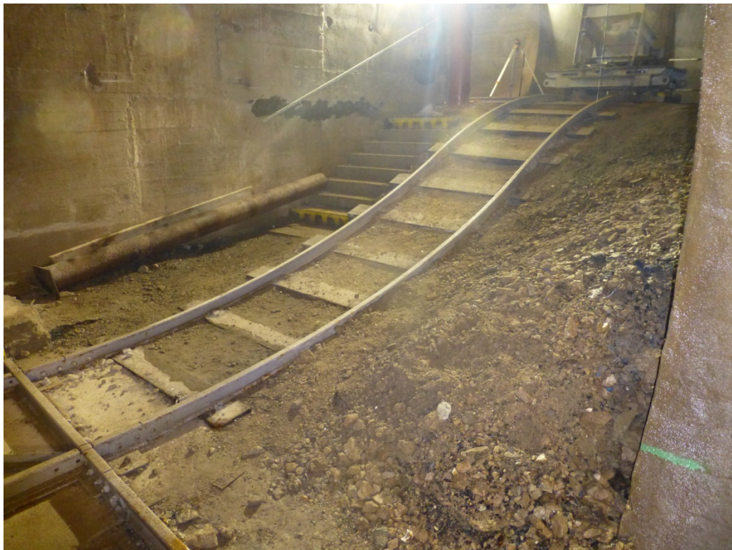
Obr.5 Změna úrovně kolejové dráhy mezi tunely č.2 a 3
